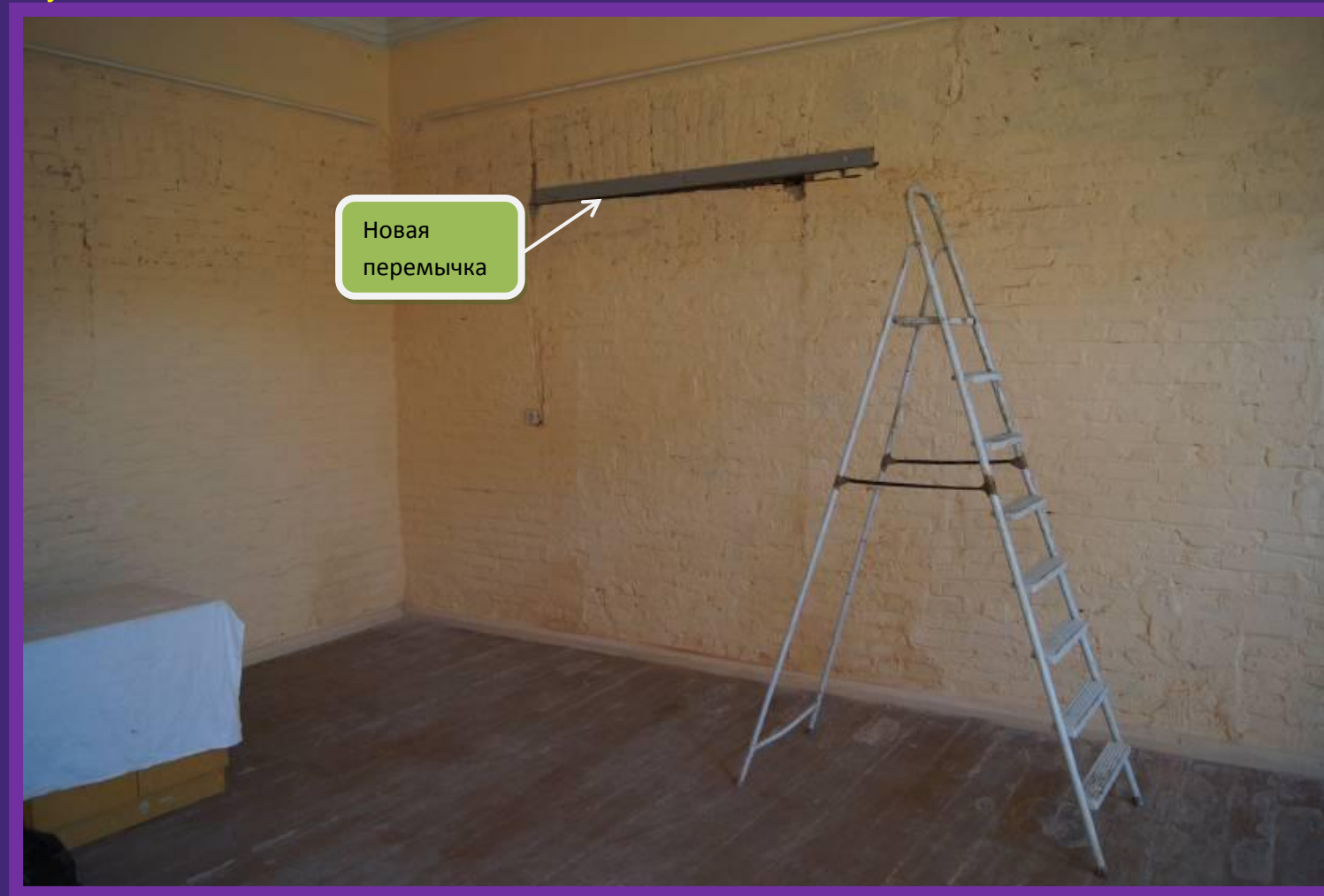
#3. Установка перемычки в пробиваемый проём
